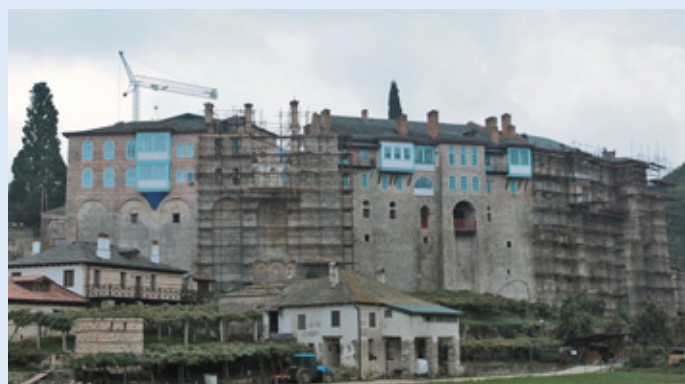
Βόρεια πλευρά της Μονής με το Μεγάλο Κονάκι, κατά τη διάρκεια της αποκατάστασης
