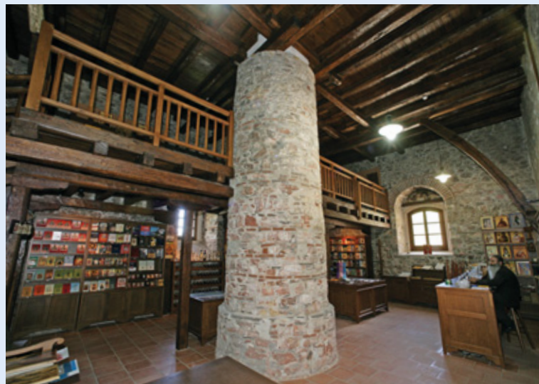
Καινούριο βιβλιοπωλείο μετά την αποκατάσταση
