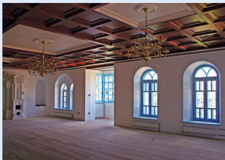
Εσωτερικός χώρος στο ανακαινισμένο κονάκι – αίθουσα τελετών στο δεύτερο όροφο
